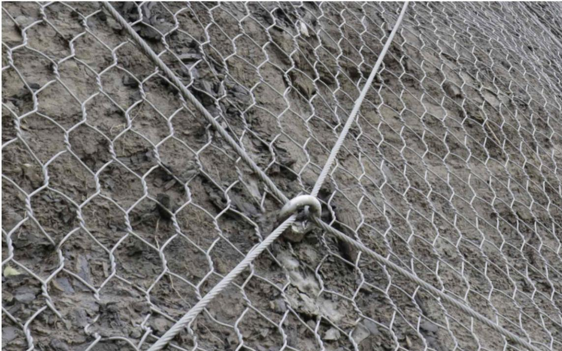
Figura 77-Particolare rete a doppia torsione, ancoraggio e funi in acciaio
